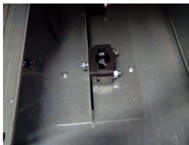
Ingresso cavi dal basso con morsetto per serraggio cavo
