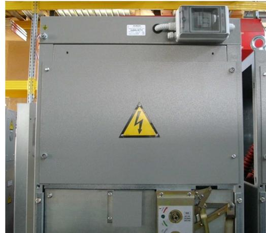
L'AC713 (matr.enel 161012) è progettato come accessorio e consente di alloggiare un trasformatore di tensione al suo interno (T.V. secondo U.E. DY543) permettendone la connessione allo scomparto accedendo direttamente dal vano sbarre.
